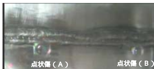
真空発泡検査における発泡の状況
